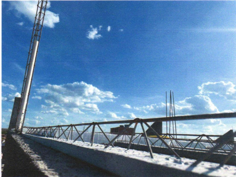
IMAGEM 07 - LAJE PRÉ-MOLDADA UNIDIRECIONAL, BIAPOIADA, PARA FORRO, VIGOTA CONVENCIONAL, ALTURA TOTAL DA LAJE (ENCHIMENTO+CAPA) = (8+3). AF_11/2020
