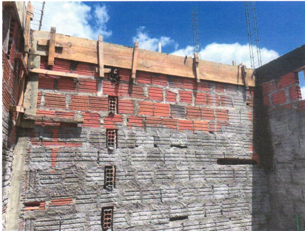
IMAGEM 01 - MONTAGEM E DESMONTAGEM DE FÔRMA DE VIGA, ESCORAMENTO COM PONTALETE DE MADEIRA, PÉ-DIREITO SIMPLES, EM MADEIRA SERRADA, 4 UTILIZAÇÕES. AF_09/2020
