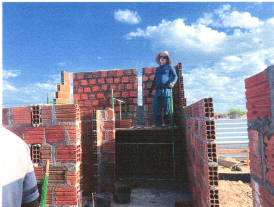
IMAGEM 09 - ALVENARIA DE VEDAÇÃO DE BLOCOS CERÂMICOS FURADOS NA HORIZONTAL DE 9X19X19 CM (ESPESSURA 9 CM) E ARGAMASSA DE ASSENTAMENTO COM PREPARO MANUAL. AF_12/2021
