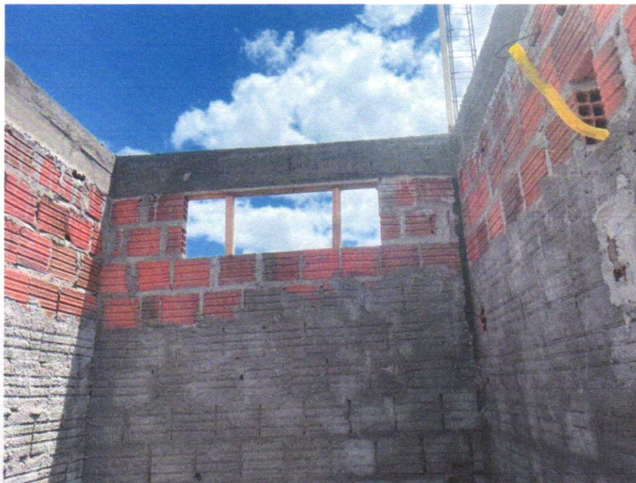
IMAGEM 03 - CONCRETAGEM DE PILARES, FCK = 25 MPA, COM USO DE BOMBA EM EDIFICAÇÃO COM SEÇÃO MÉDIA DE PILARES MENOR OU IGUAL A 0,25 M 2 - LANÇAMENTO, ADENSAMENTO E ACABAMENTO. AF_12/2015
